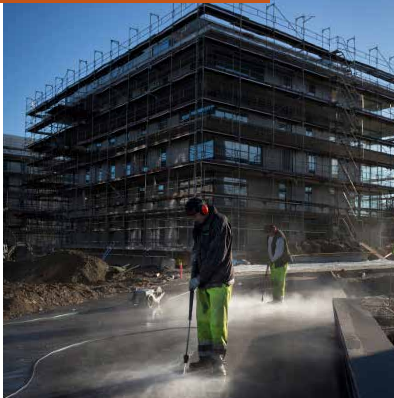
Photographie tirée du livre Genèse d'un quartier retraçant les étapes du chantier, publié par la Ville de Lancy et réalisé par Marie-Anne et Thierry Camail.
